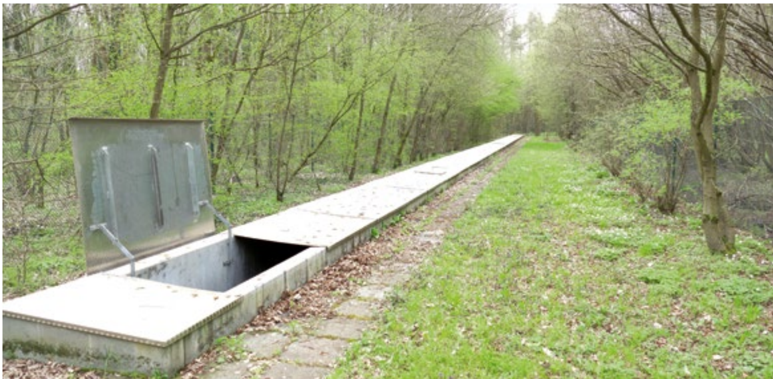
Sickerschlitzgraben zur Grundwasseranreicherung in der Nähe des Wasserwerkes Allmendfeld.
