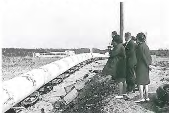
Zusammgebauter Düker auf dem Festland kurz vor seiner Verlegung in das Flußbett
