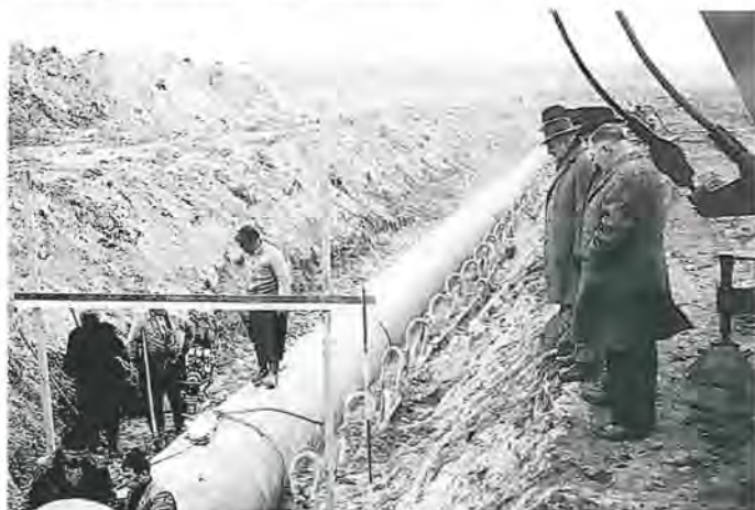
Verlegung von Spannbeton- druckrohren mit Soccoman- muffen Ø 1000 mm unter Wasserhaltung im Raum Gernsheim-Allmendfeld
