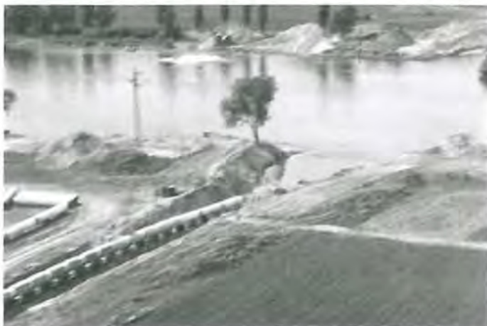
Verschiedene Ansichten des Dükers kurz vor der Verlegung in das Flußbett
