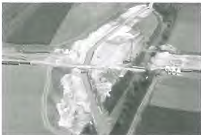
Verlegung des Bachbettes des Landgrabens im Raum Groß-Gerau/Wallerstädten im Zuge der Verlegung einer Spannbetondruckrohrleitung Ø 1300 mm
