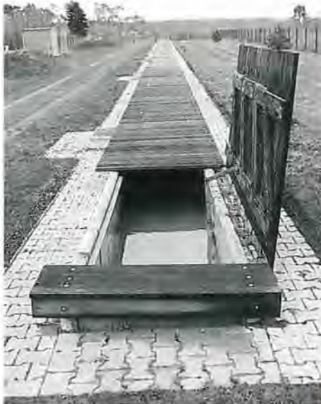
Sickerschlitzgraben zur Grundwasseranreicherung
