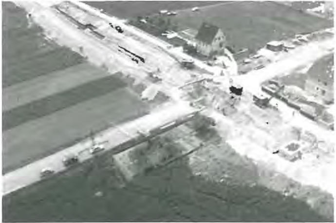
Unterdükerung von Bundesstraße (B44) und nebenliegender Eisenbahnlinie (Frankfurt-Mannheim) im Raum Stockstadt-Erfelden unter Aufrechterhaltung des Verkehrs
