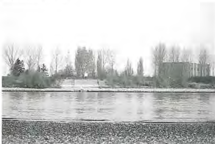
Entnahmebauwerk am rechten Rheinufer bei Biebesheim mit Rohwasserpumpwerk
