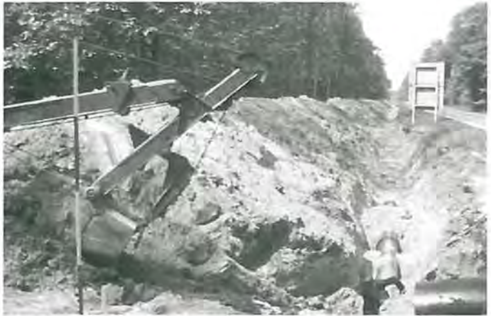
Rohrverlegung im Rüsselsheimer Wald, Baulos VIII, Spannbetonrohre Ø 1000 mm
