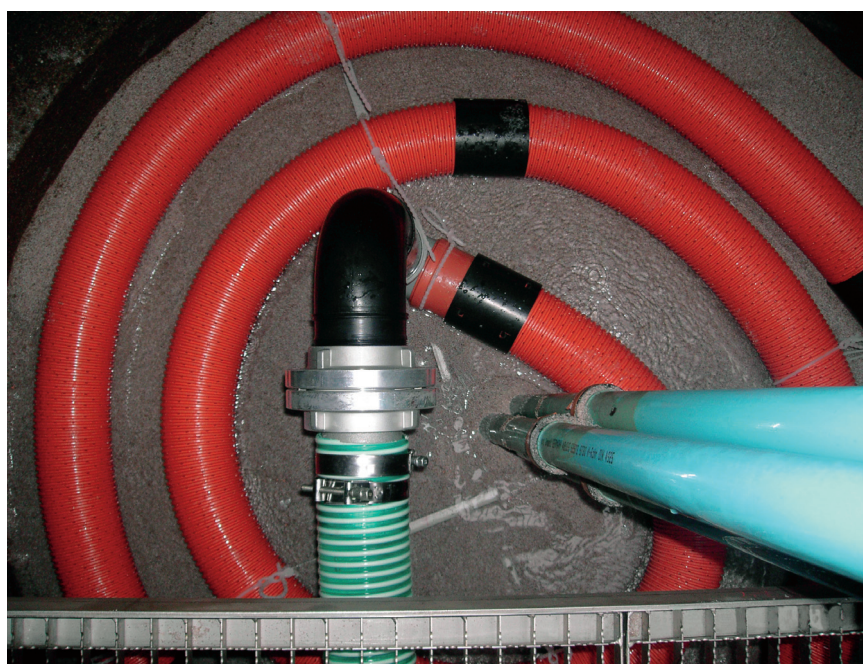
Abb. 3 Ausbau eines Kiesbohrlochs mit Einlaufschnecke
