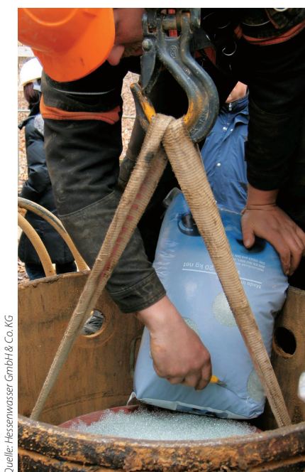
Abb. 2 Ausbau eines Schluckbrunnens mit Glaskugeln als Stützgerüst
