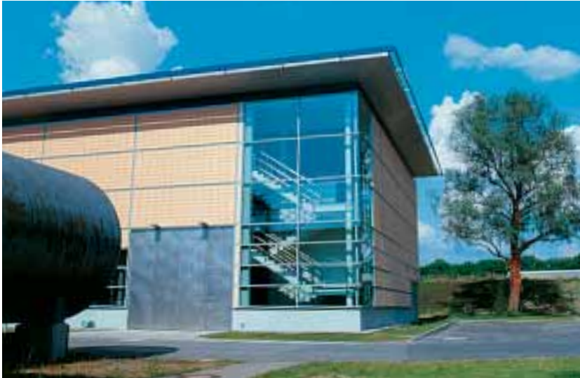
Blick auf die neue und alte Filterhalle, 2000
