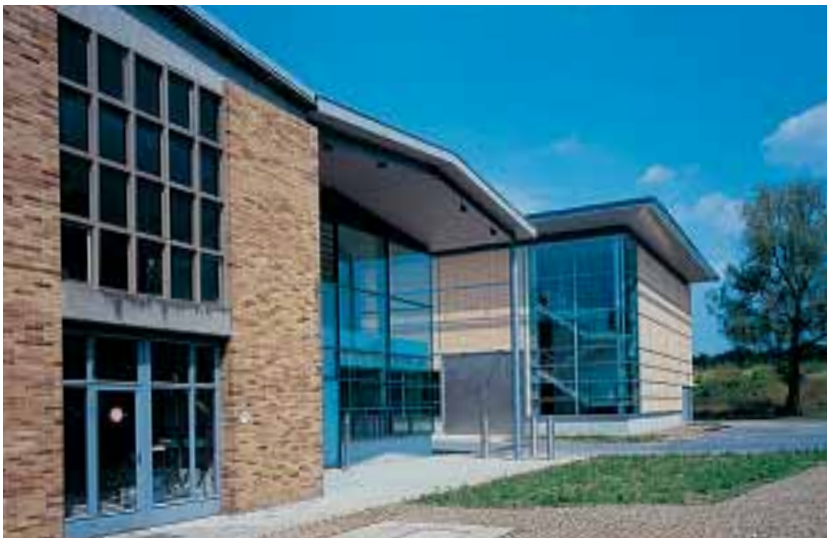
Blick auf die neue Filterhalle und den Eingang zur neuen Leitwarte, 2001
