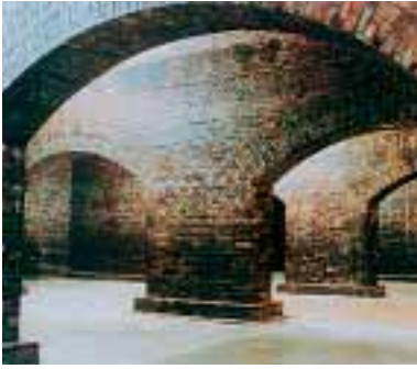
Innenraum des Hochbehälters auf der Mathildenhöhe
