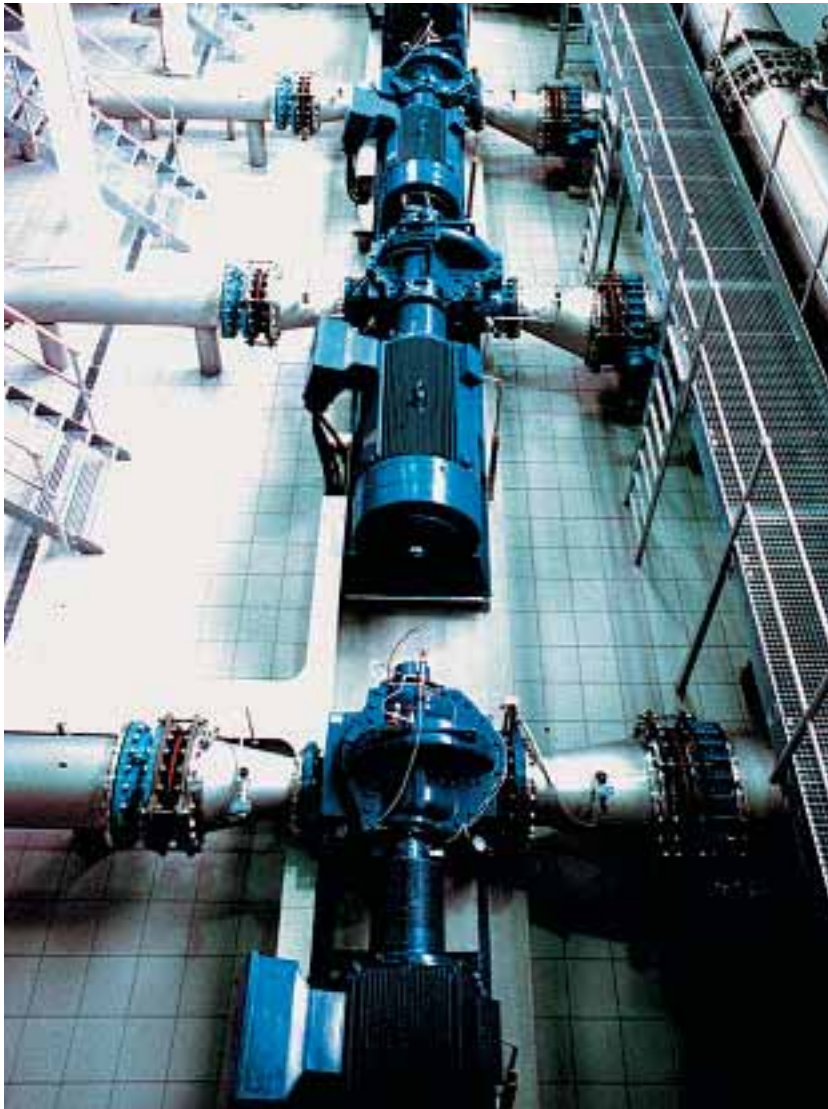
Die neue Maschinenhalle
