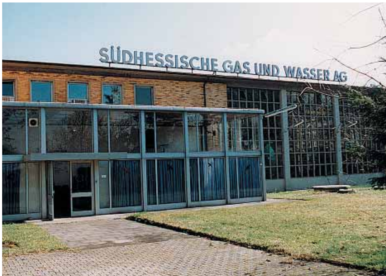
Wasserwerk 1, Blick auf Eingangshalle und Maschinenhaus, Fotografie 1997
