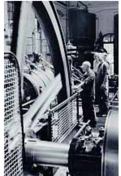
Blick in das Maschinenhaus um 1930
