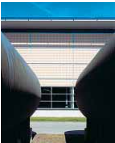
Blick durch die horizontalen Filterkessel auf die neue Filterhalle, 2000
