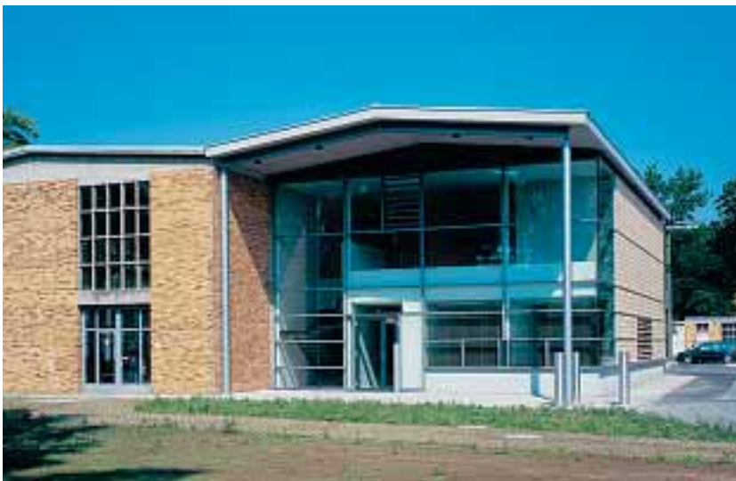
Blick von Süden auf den Eingang zur neuen Leitwarte, 2001
