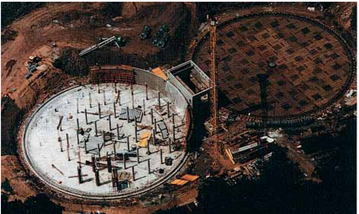
Der „Brillenbehälter“ im Oberfeld im Bau
