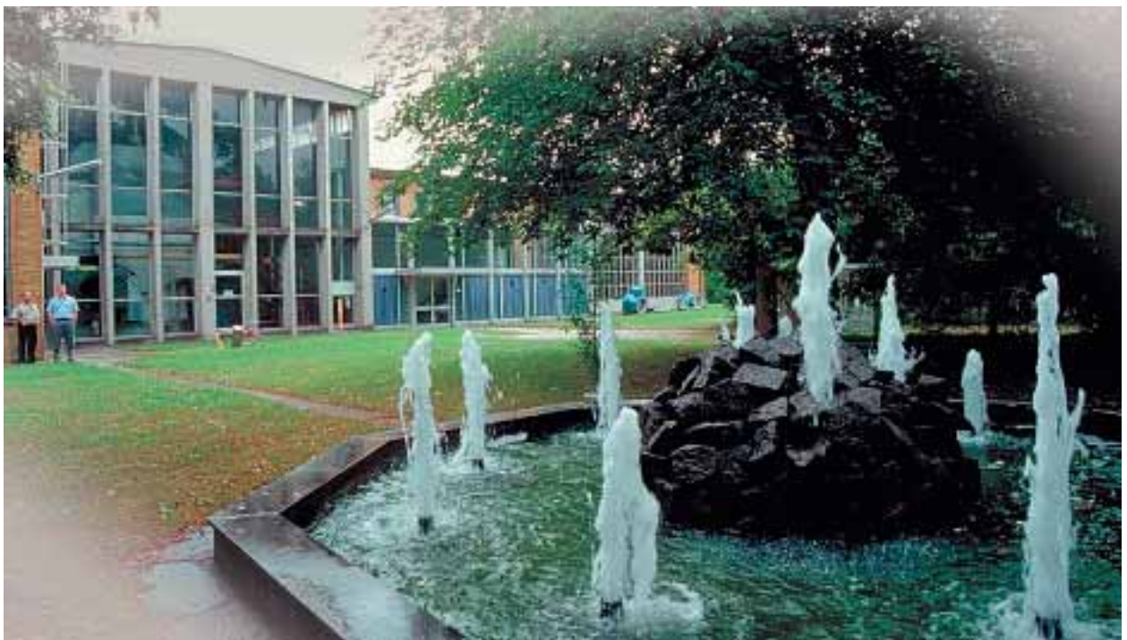
Wasserwerk 1, Blick auf Kesselhaus und Eingangshalle
