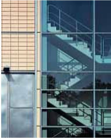
Blick von Westen auf die neue Filterhalle, Treppenhaus
