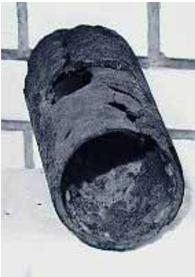
Typische Schadensbilder an eisernen Wasserrohren: Rostfraß und Ablagerungen im Rohr
